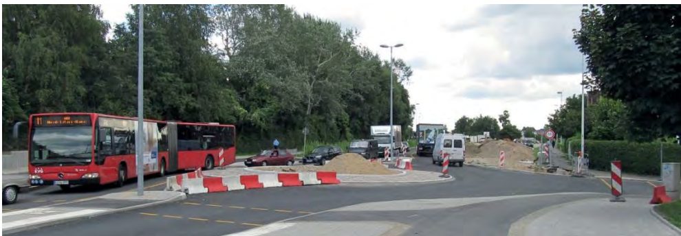
Abbildung 13: Bau des neuen Langer Rehms mit Kreisverkehr im August 2016
