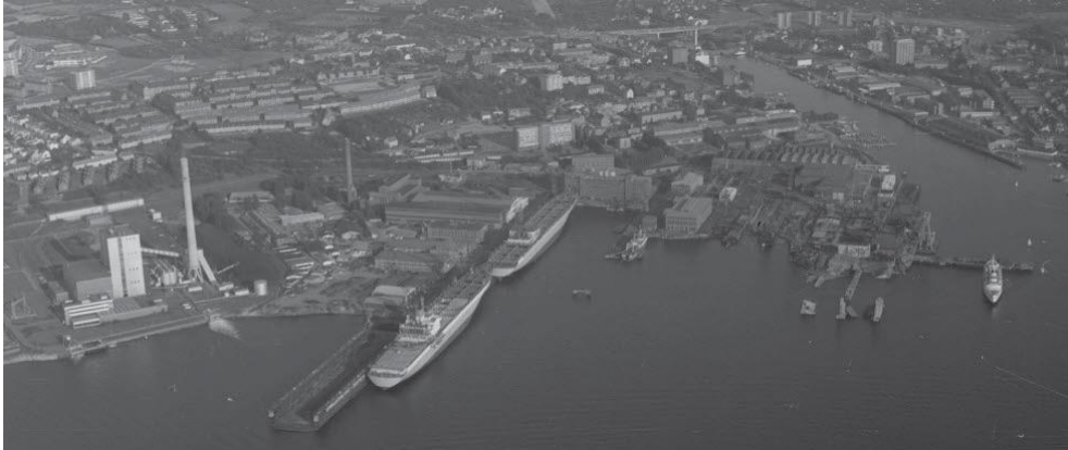
Abbildung 7: Blick auf Neumühlen-Dietrichsdorf Richtung Osten 1972 (Stadtarchiv Kiel)
